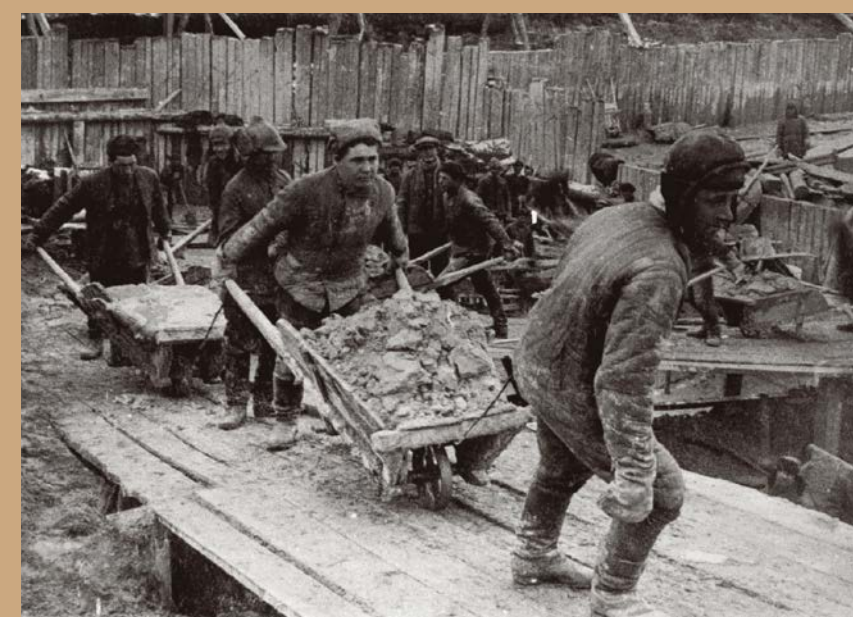
3 Заложенные на строительстве Беломорско-Балтийского канала. Начало 1930-х гг.
